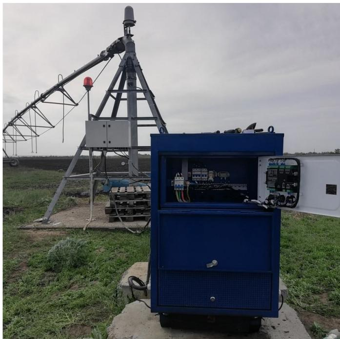
Рисунок 4. Подведение питания дождевальной машины кругового типа «КАСКАД» от дизель-генератора
